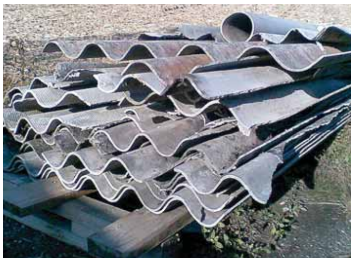
Nelle lastre di amianto si nasconde un pericoloso killer
